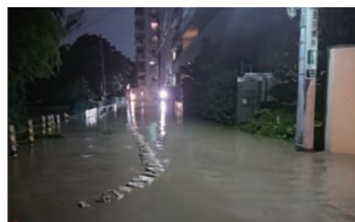
多摩川無堤防地区からの溢水
