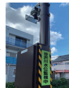
かねてより要望していた河川カメラと危険水位表示
