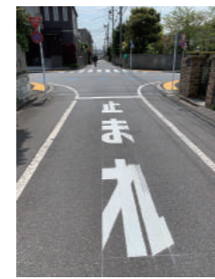
薄くなった停止線を塗り直し
