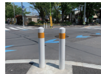
交差点の角にポールを設置
