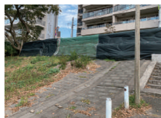
台風19号で溢水した区間に大型土のう設置を要望
