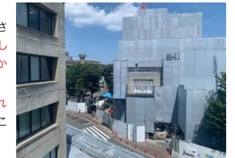
▲1期工事は10F建ての東棟が対象
