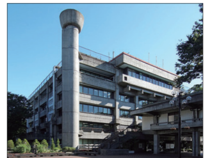
築56年となる第一庁舎。東日本大震災の際、窓ガラスが約70枚破損。
