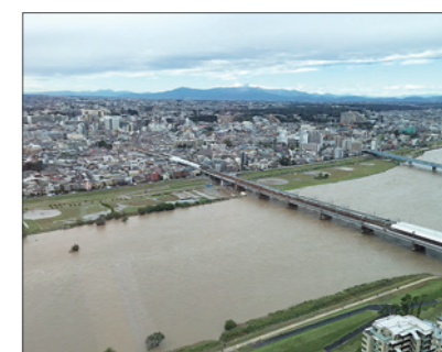
台風によりグラウンドが水没。堤防整備が急務。
