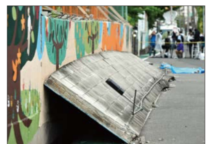
公共施設のブロック塀の耐震性緊急調査を実施。
