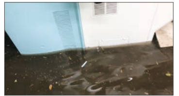
用賀中町通り沿いの店舗も軒並み浸水。
