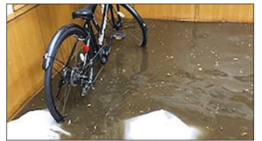
降り出してからわずか10分後の様子。
